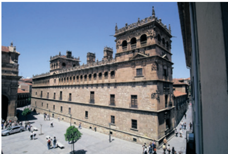
Foto 42: Parte frontal de muralla principal del Palacio de Monterrey 393
